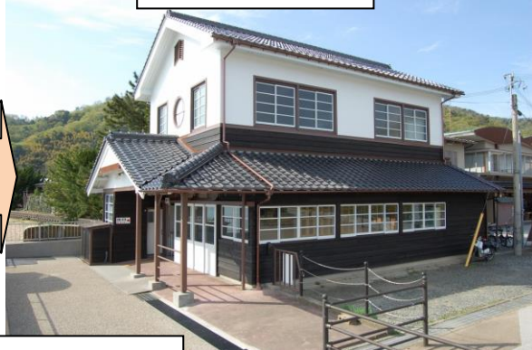
一の宮駅 改修工事
