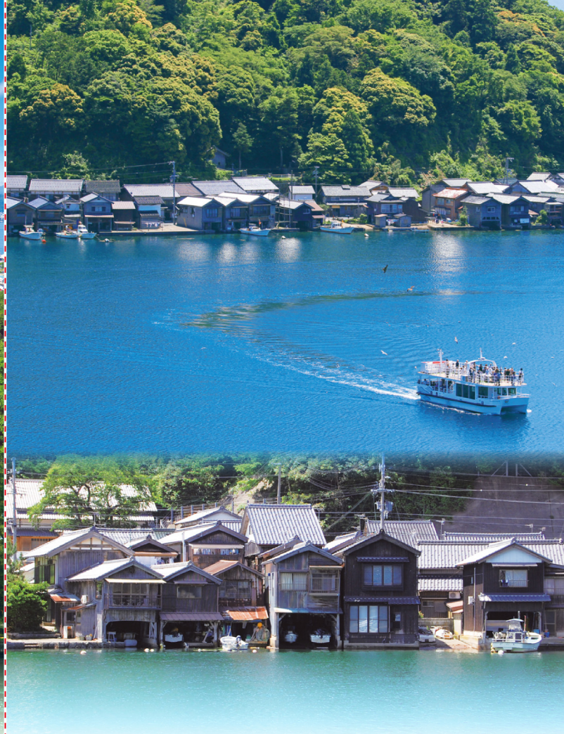
伊根湾めぐり遊覧船・重要伝統的建造物群保存地区「伊根の舟屋」 Ine Bay Cruising / Ine no Funaya Boathouse
