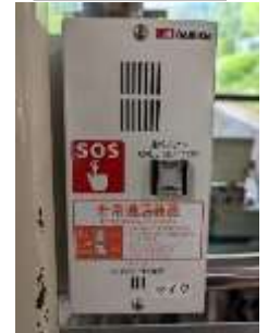
非常通報装置
